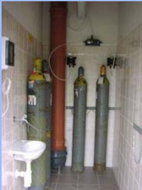
Tlakové nádoby s plynným chlórem
